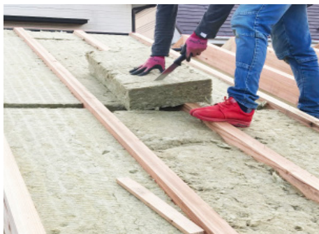
充填用ストーンウールを断熱用ナイフで カットしている様子
