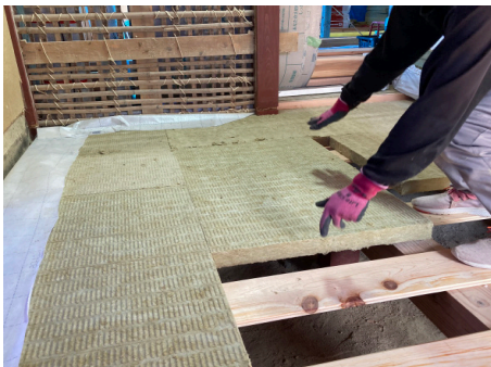
トライロック Yuka S150を 荒床材の上に敷き詰めている様子
