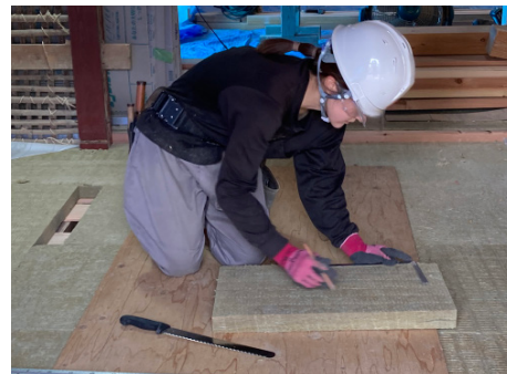
必要寸法を確認し、断熱用ナイフで 現場加工を行う様子
