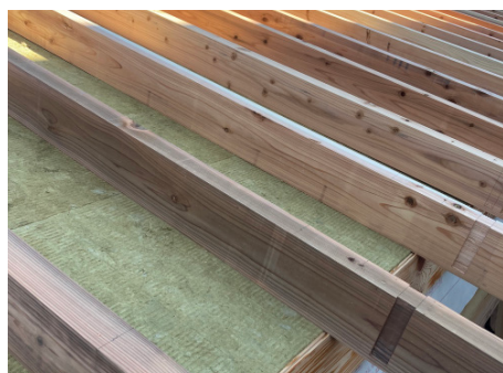
高さのガイドを棟部に設置された様子
