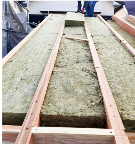
通気垂木間の充填施工の様子
