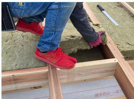
軒部の充填で、通気を確保し設置している 様子
